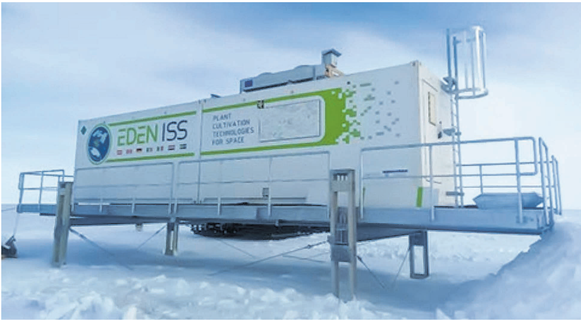
Für dieses Gewächshaus in der Antarktis hat ISW den Bau einer Kühlung geplant.
